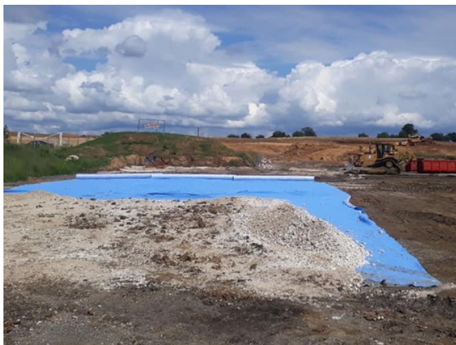
Figure 2: Recouvrement de l'aquatextile de la zone de stationnement des engins de chantier par une couche de surface perméable.
