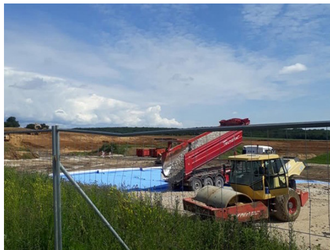
Figure 2: Recouvrement de l'aquatextile de la zone de stationnement des engins de chantier par une couche de surface perméable.
