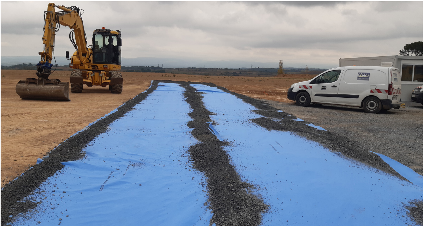
Figure 1 : Posez les bandes d'OSMORIA Geoclean sur la zone de stationnement prévue. Commencez à les lester avec du matériau granulaire, en commençant par les chevauchements et les bords pour éviter les perturbations dues au vent.
