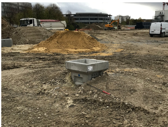
Figure 3: Puits d'injection avec décanteur, pour collecter les eaux pluviales d'une surface imperméable et les injecter dans la structure réservoir. Le décanteur réduit la quantité de particules solides qui s'introduisent dans l'ouvrage enterré.
