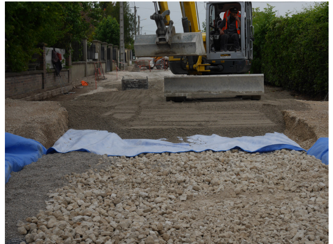
Figure 7: Remblaiement au-dessus de la structure réservoir emballée par l'aquatextile
