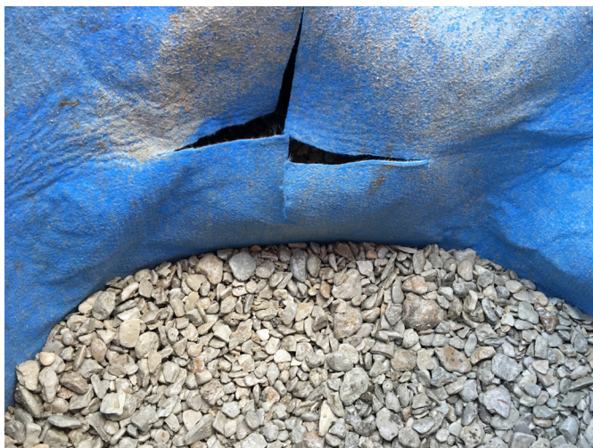
Figure 1: Découpe de l'aquatextile « en croix » pour le passage de la conduite
