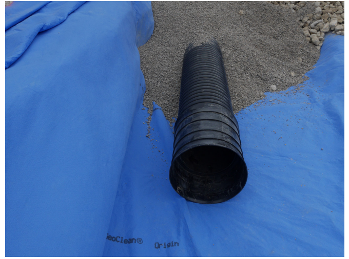
Figure 5: Structure réservoir granulaire sur OSMORIA Geoclean avec conduite perforée d'amenée des eaux brutes
