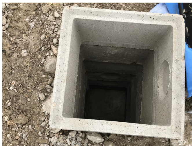
Figure 3: Puits d'injection avec décanteur, pour collecter les eaux pluviales d'une surface imperméable et les injecter dans la structure réservoir. Le décanteur réduit la quantité de particules solides qui s'introduisent dans l'ouvrage enterré.
