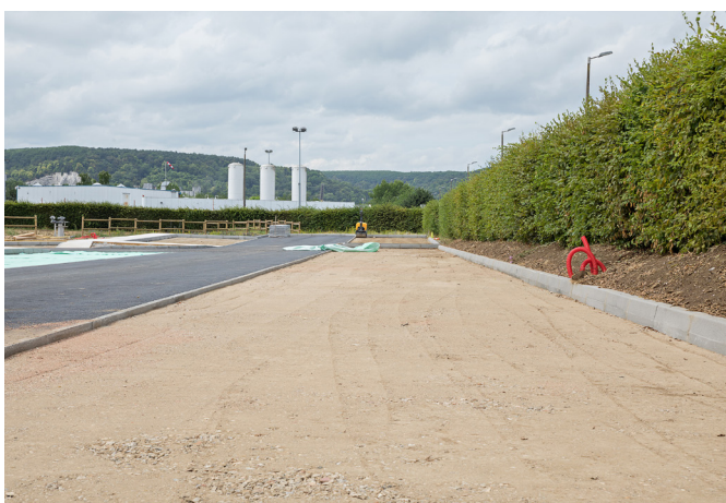
Figure 5: Terrassement du lit de pose et pose du revêtement perméable (photos à droite : dalles alvéolaires)
