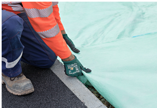
Figure 3: Le chevauchement des lés devra d'être d'au moins 30 cm sur les parties planes horizontales. OSMORIA Indigreen devra remonter verticalement de 10 à 20 cm, selon l'épaisseur de la structure de revêtement perméable, sur la périphérie de la zone traitée
