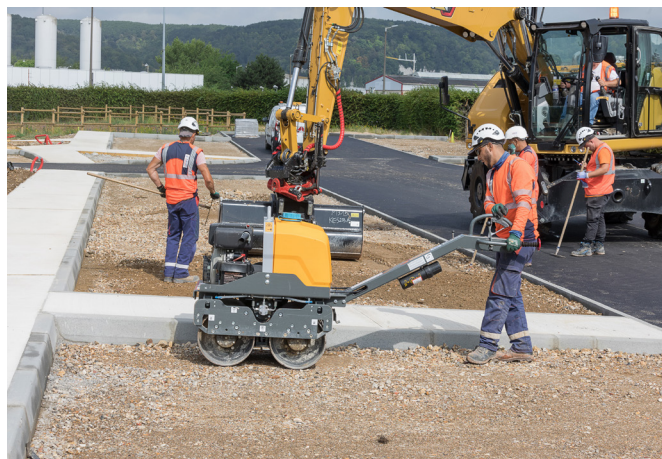
Figure 1: Terrassement de la couche de forme
