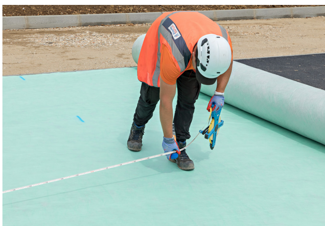
Figure 2: Mesure et découpe des lés si l'ouvrage le requiert
