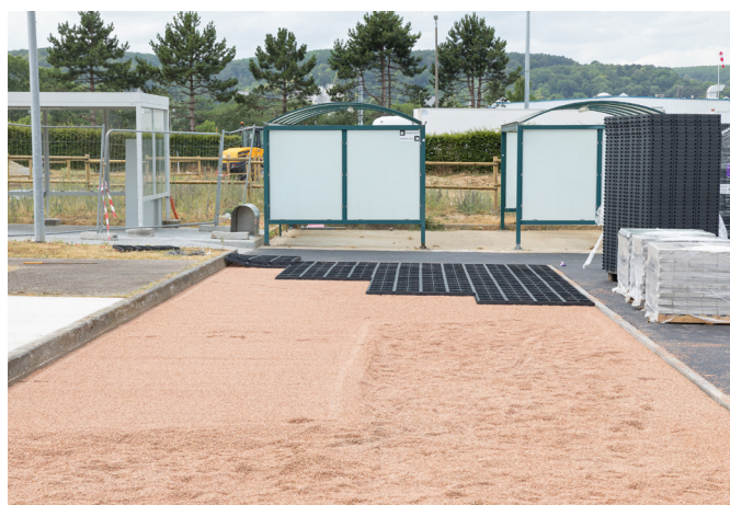
Figure 5: Terrassement du lit de pose et pose du revêtement perméable (photos à droite : dalles alvéolaires)
