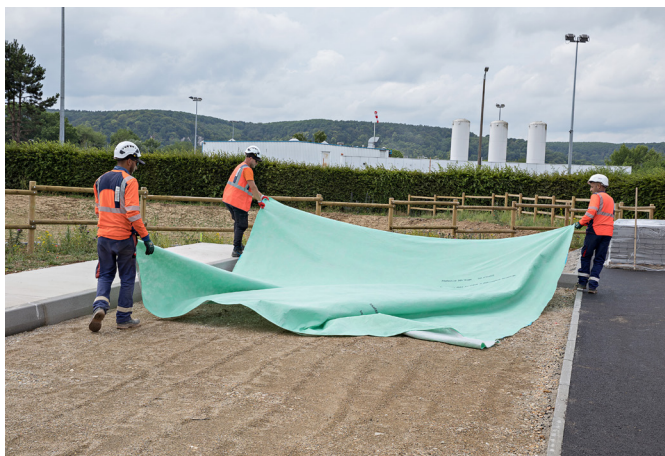
Figure 3: Le chevauchement des lés devra d'être d'au moins 30 cm sur les parties planes horizontales. OSMORIA Indigreen devra remonter verticalement de 10 à 20 cm, selon l'épaisseur de la structure de revêtement perméable, sur la périphérie de la zone traitée
