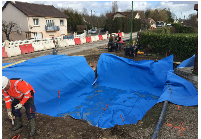
Figure 4: Mise en place des lés d'aquatextile en fond et sur les côtés
