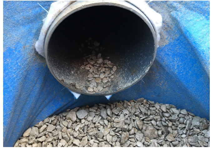
Figure 2: Traversée de l'aquatextile par la conduite dans la découpe
