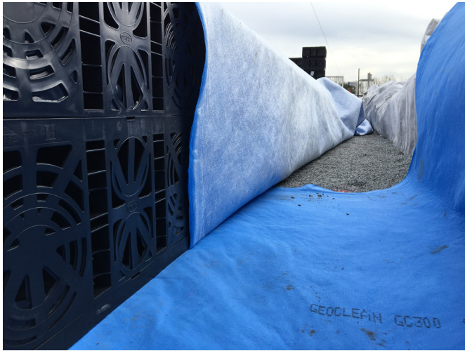
Figure 6: Remontée des lés sur les parois
