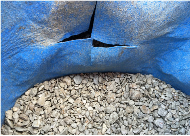
Figure 1: Découpe de l'aquatextile « en croix » pour le passage de la conduite
