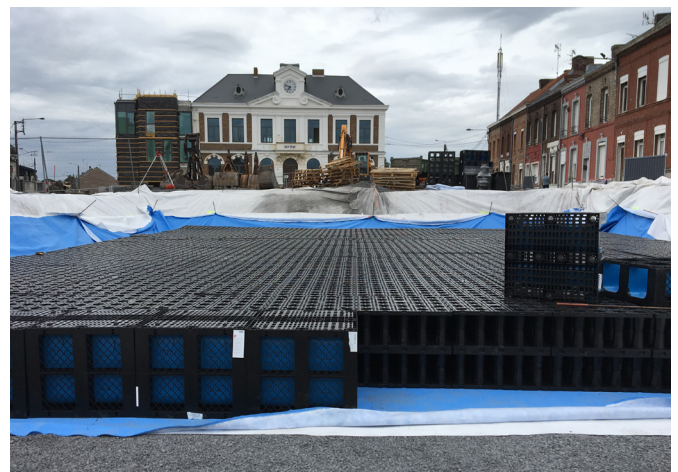
Figure 4: Mise en place des lés d'aquatextile en fond et sur les côtés
