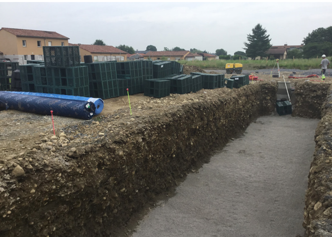
Figure 3: Préparation de la surface de pose (ici couche drainante)
