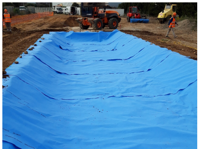
Figure 1: Mise en place des lés d'aquatextile sur le fond et sur les talus - Lestage en tête par plots de terre
