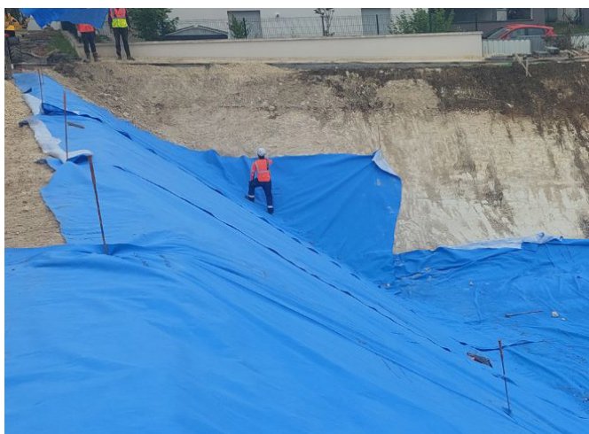
Figure 4: Piquetage pour maintenir les lés en tête de talus
