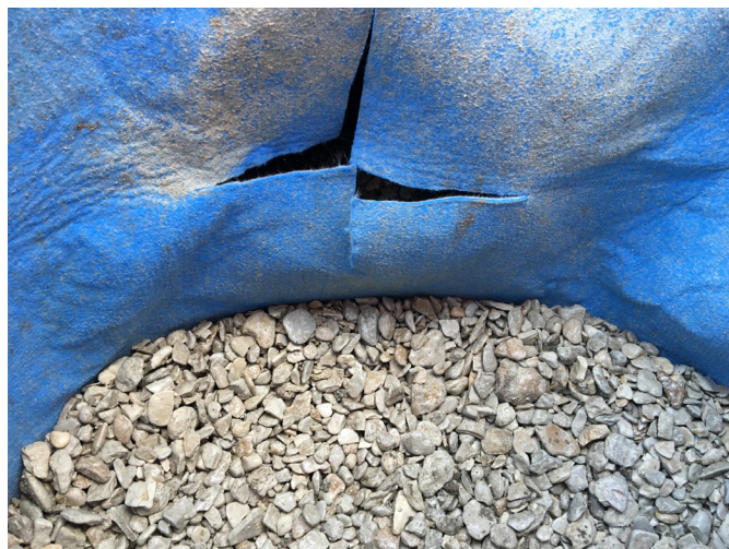
Figure 2: Découpe de l'aquatextile « en croix » pour le passage de la conduite
