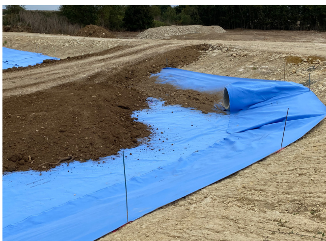
Figure 6: Couverture de l'aquatextile du bassin d'infiltration par de la terre végétale perméable
