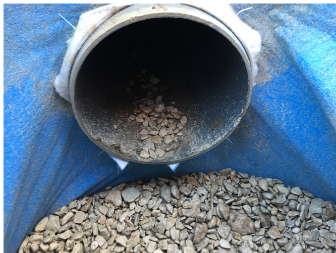
Figure 3: Traversée de l'aquatextile par la conduite dans la découpe
